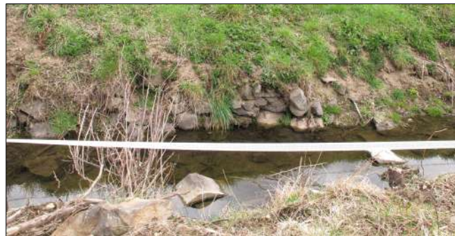
Photo 37 : Au centre de la photo, muret vertical en rive droite du béal en assez bon état, et à droite état après écroulement du muret.
