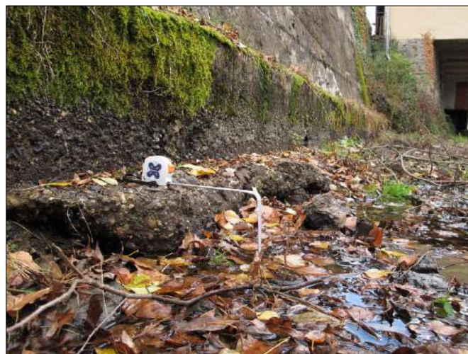
Photo 40 : Creusement naturel du béal aval de 10 à 16 cm hors sol cimenté à proximité des parcelles AE 241 et 242.
