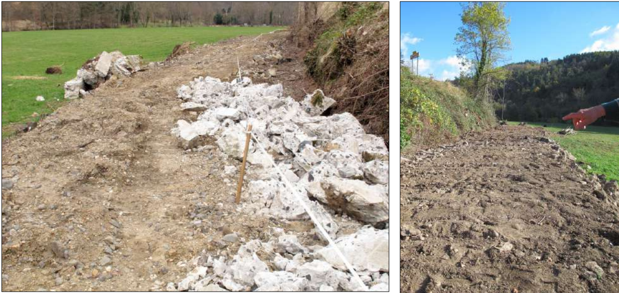
Photo 6 : État du béal aval après son arasement, avec à gauche indication de la limite de la parcelle du béal par un ruban blanc.
