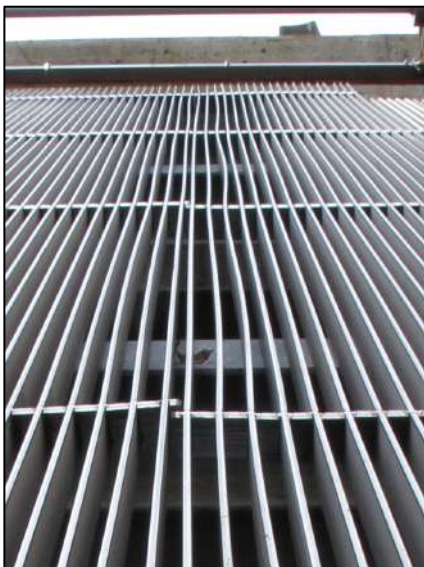
Photo 19 : Grille du dégrilleur : fers tordus par endroits (à gauche), d'où des espacements entre fers allant jusqu'à 26 mm au moins (à droite).
