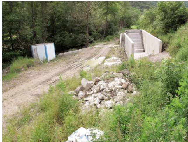
Photo 12 : Parcelle AE 226 après travaux, avec, à droite, le béal reconstruit puis le dégrilleur et, au fond au milieu, le déversoir (cliché pris le 8 juin 2018).
