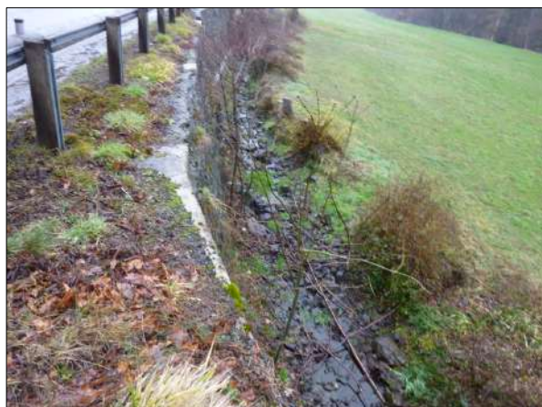
Photo 9 : État actuel du béal amont : photos de l'auteur les 28 octobre et 19 novembre 2017, et (en bas) d'un huissier de justice le 20 février 2018 76 (page 24).
