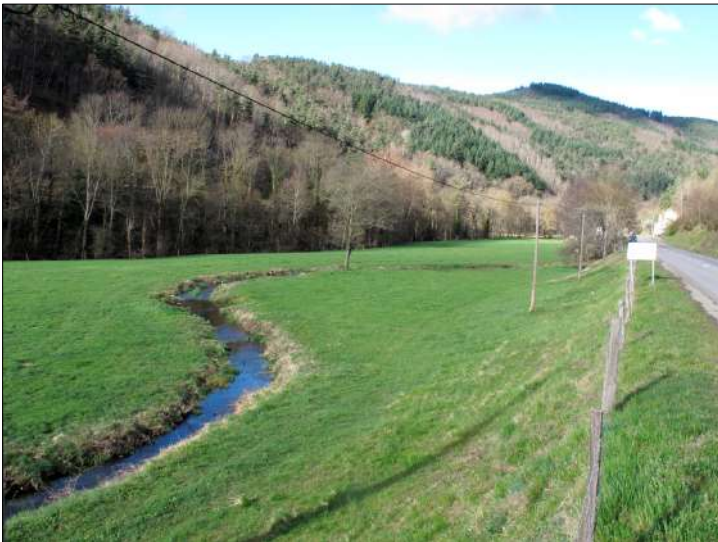
Photo 20 : Vue du béal amont serpentant dans les prés, avant travaux.
