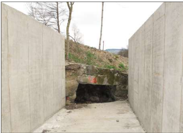
Photo 4 : Début du béal amont reconstruit entre le pont sur l'ancien béal et le dégrilleur.
