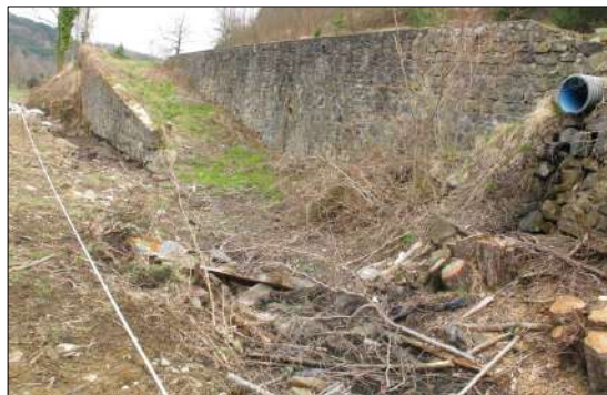
Photo 11 : Déversement des eaux pluviales de la route départementale dans le béal (arasé au cours des travaux), et indication de la limite de la parcelle du béal par un ruban blanc (sur la gauche de la photo).
