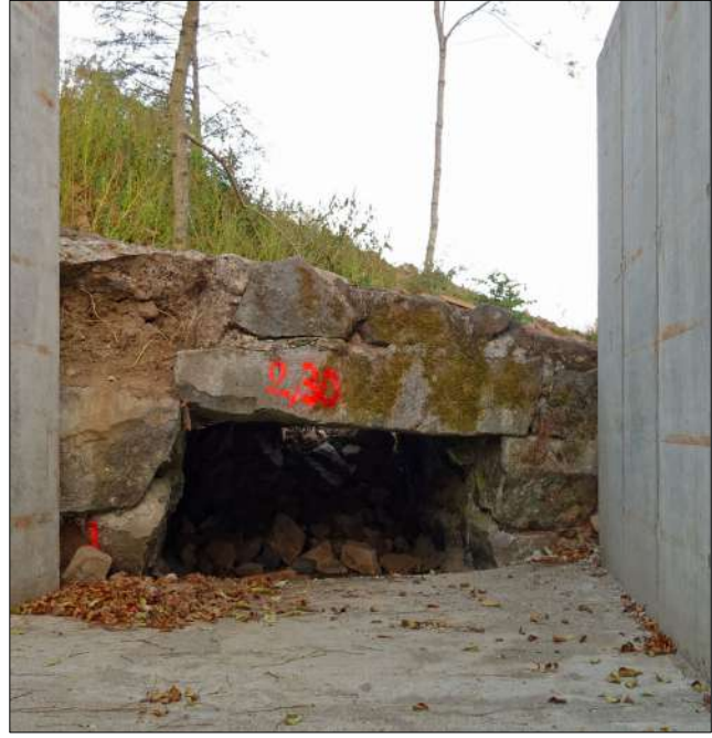
Photo 39 : Pont juste en amont du dégrilleur, à 488 m de la vanne d'entrée, vu de l'aval le 26 octobre 2017.
