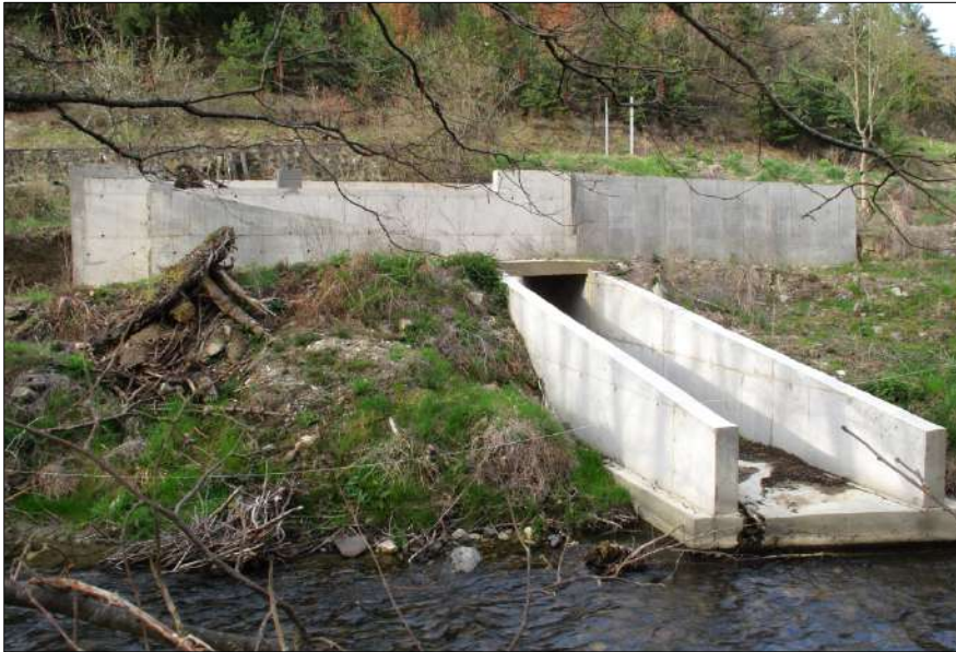
Photo 3 : Dégrilleur, début du béal amont rehaussé et déversoir terminés fin octobre 2017. Le pont sur l'ancien béal est à droite de la photo et immédiatement à droite du mur du béal rehaussé.
