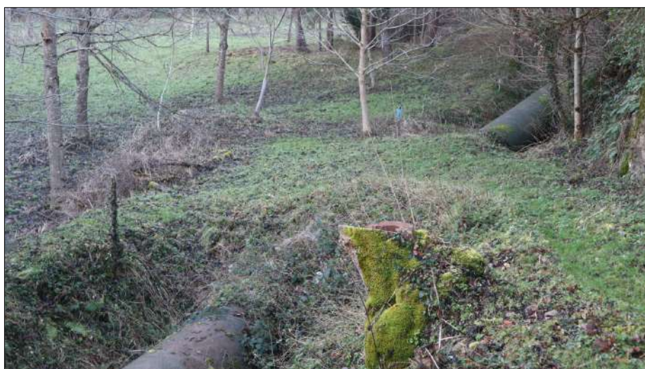
Photo 46 : Vue de la conduite forcée alimentant la microcentrale de Chazelles, le 23 janvier 2018.
