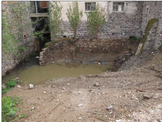
Photo 8 : État du chantier de la turbine à la suite des travaux effectués du 6 au 12 février et du 10 au 17 avril 2019.
