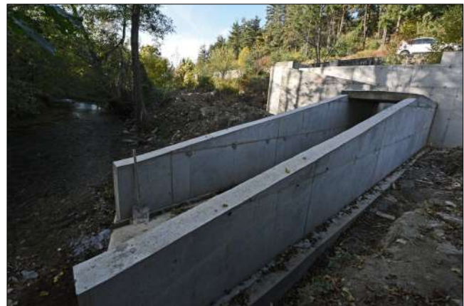
Photo 5 : Déversoir donnant sur la Desges à gauche et dégrilleur le 13 octobre 2017.
