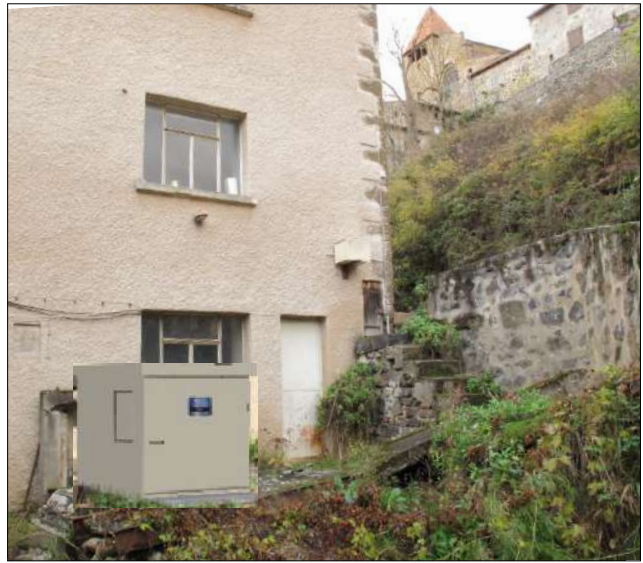
Photo 23 : Simulation des projets successifs de transformateur. Celui-ci fait 1,40 m de haut, 1,31 m de large et 1,44 m de profondeur.
