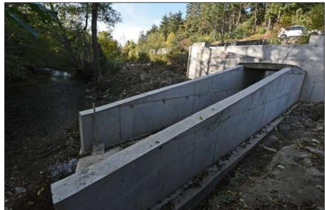
Photo 6 : Déversoir donnant sur la Desges à gauche et dégrilleur le 13 octobre 2017.
