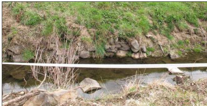
*Photo 38 : Au centre de la photo, muret vertical en rive droite du béal en assez bon état, et à droite état après écroulement du muret.*
