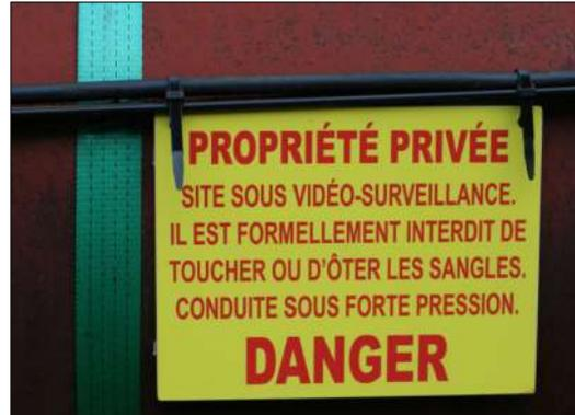
*Photo 25 : Fuite sur la conduite forcée alimentant la microcentrale de Desges, ceinturée de sangles tous les 60 cm, et panneau de danger, le 23 janvier 2018. La fuite n'est heureusement pas dirigée vers le chemin adjacent. La conduite a été remplacée depuis lors.*
