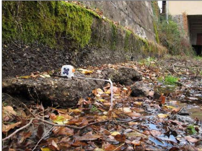
*Photo 42 : Creusement naturel du béal aval de 10 à 16 cm hors sol cimenté à proximité des parcelles AE 241 et 242.*
